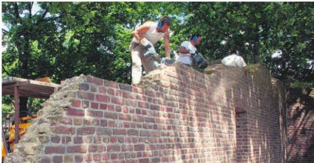
Statt für Menschen werde Geld für die Sanierung der Stadtmauer ausgegeben, kritisiert eine Leserin. Ein Leser sieht den Einsturz als symbolisch für Mängel in der Bergheimer Infrastruktur. Foto: Vlaminc
